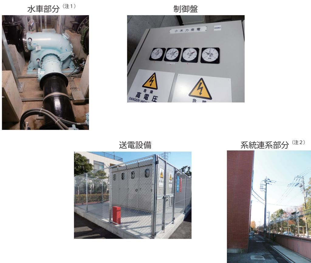
(注 1) 水色のかたつむり型の水車の下部を床に埋めて設置
