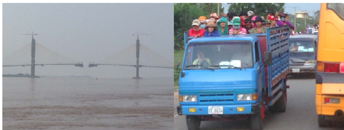
完成に近づくネアックルン橋（左図）、工業団地から帰宅しているワーカー達（右図）
